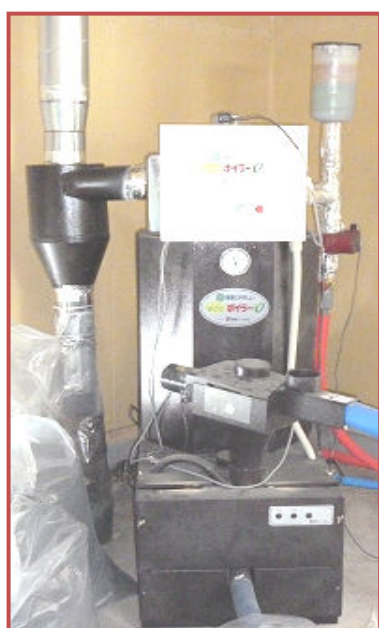
もみ殻ボイラー外観
